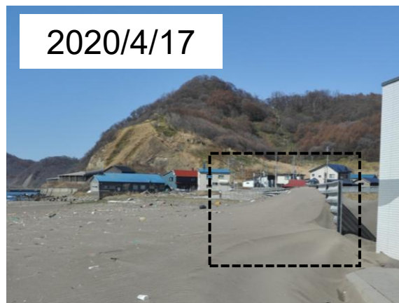
設置された防砂フェンスが埋没
